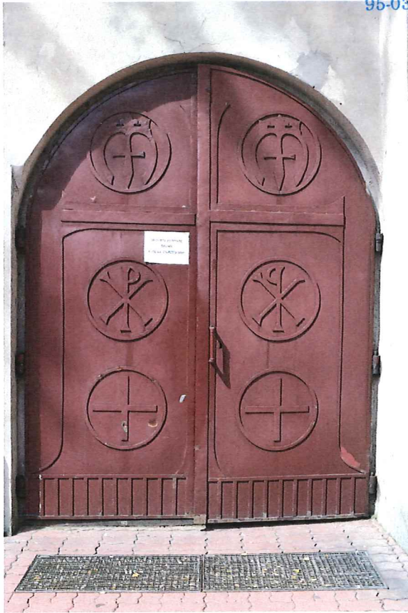
Fot. 38. Stalowe wrota do kruchy wieżowej;
