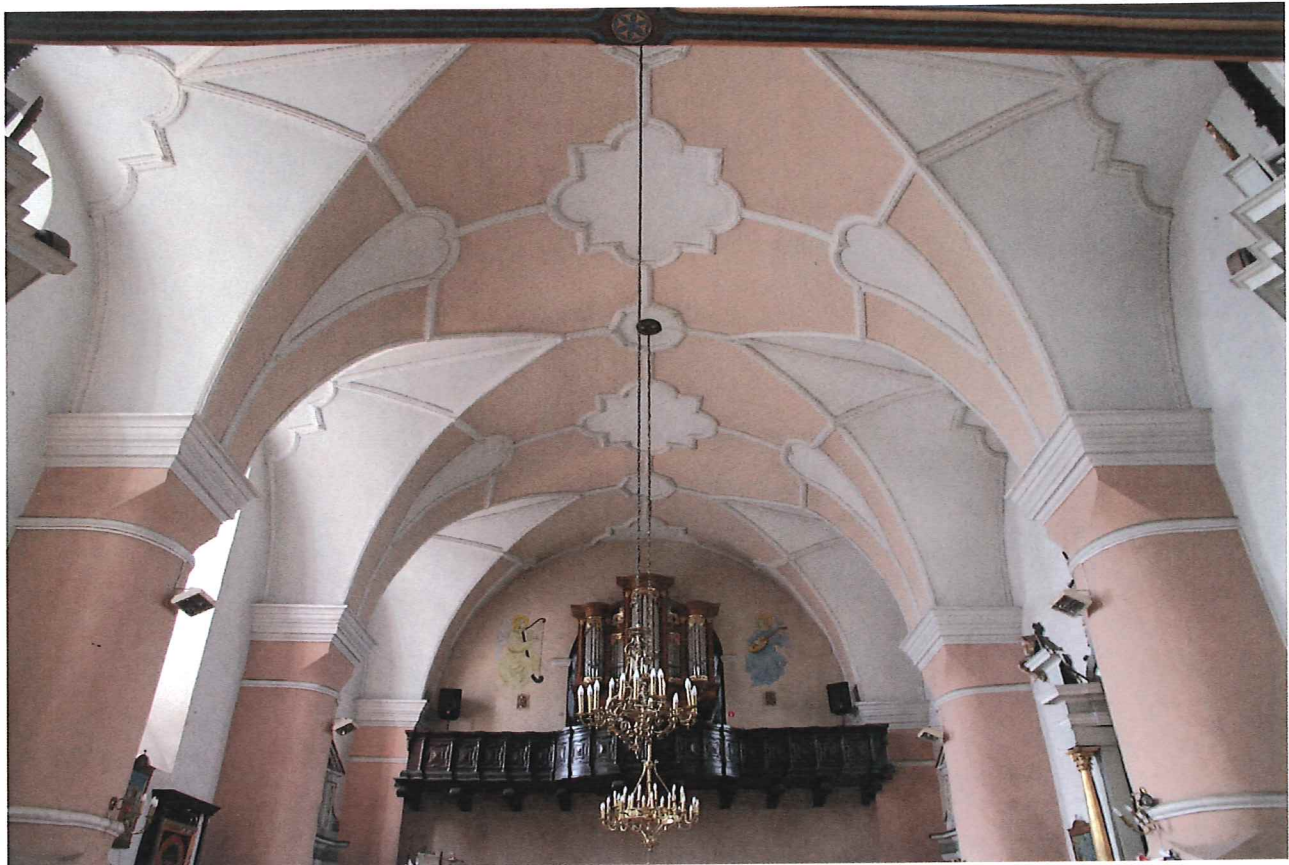
Fot. 4. Widok ogólny wnętrza kościoła - sklepienia nawy i ściana zachodnia.
