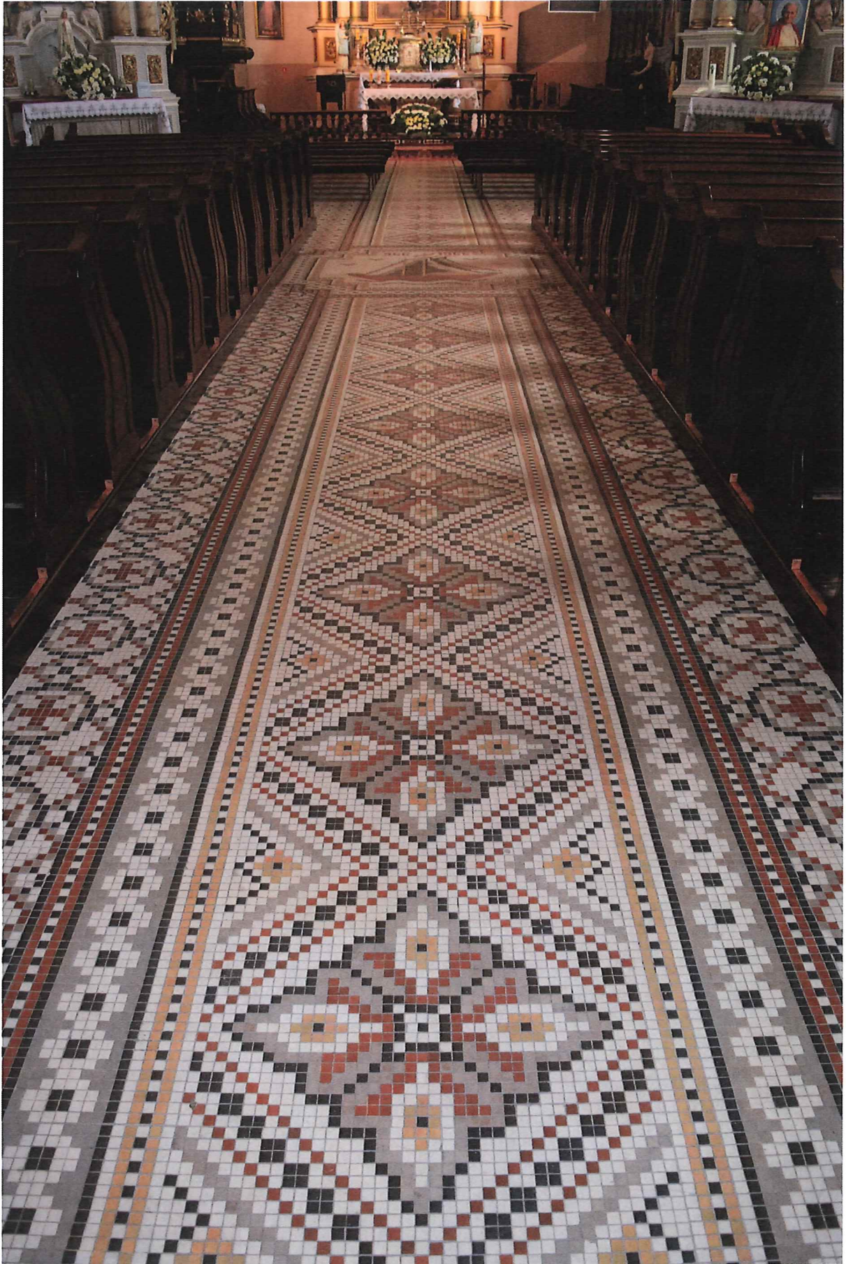
Fot. 19. Posadzka w nawie, pochodząca z lat 60-tych XXw.
