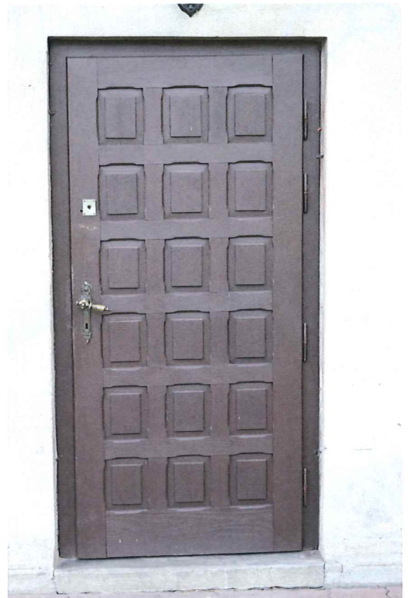
Fot. 46. Drzwi do zakrystii.
