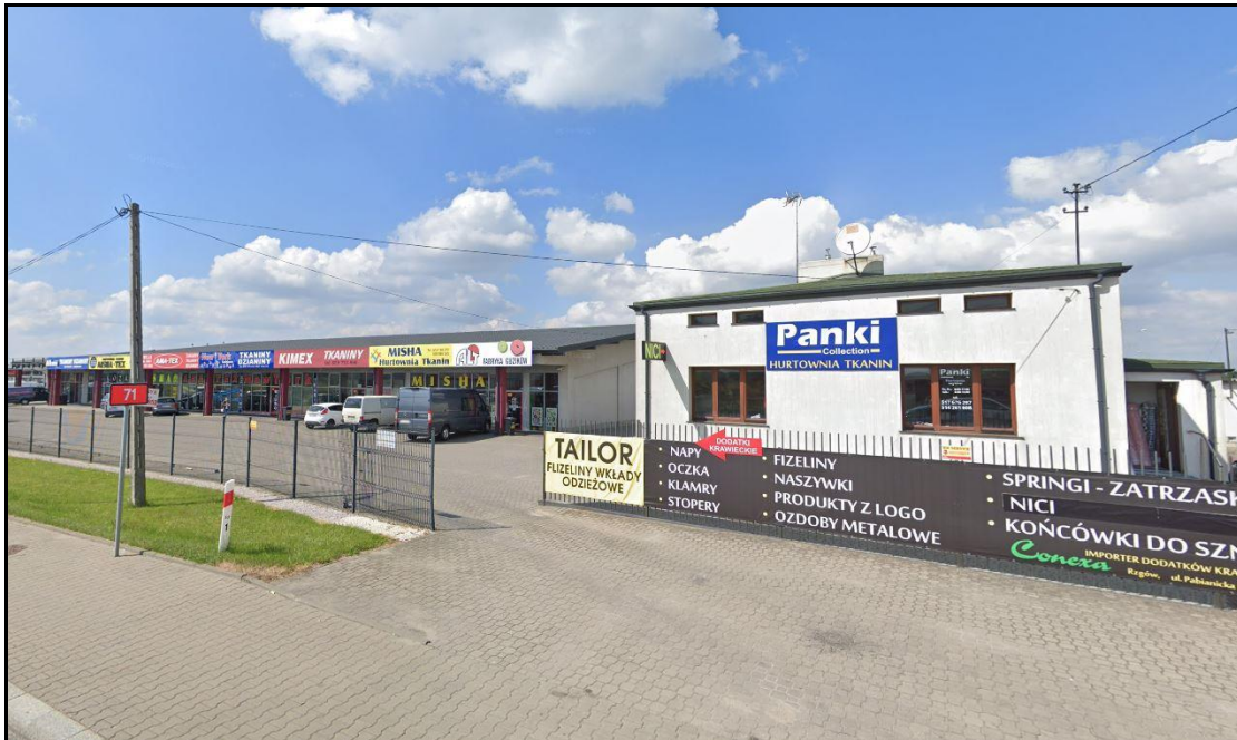
Rys. 3 Widok na południową część omawianego obszaru od strony drogi krajowej Nr 71 (ul. Pabianickiej)
