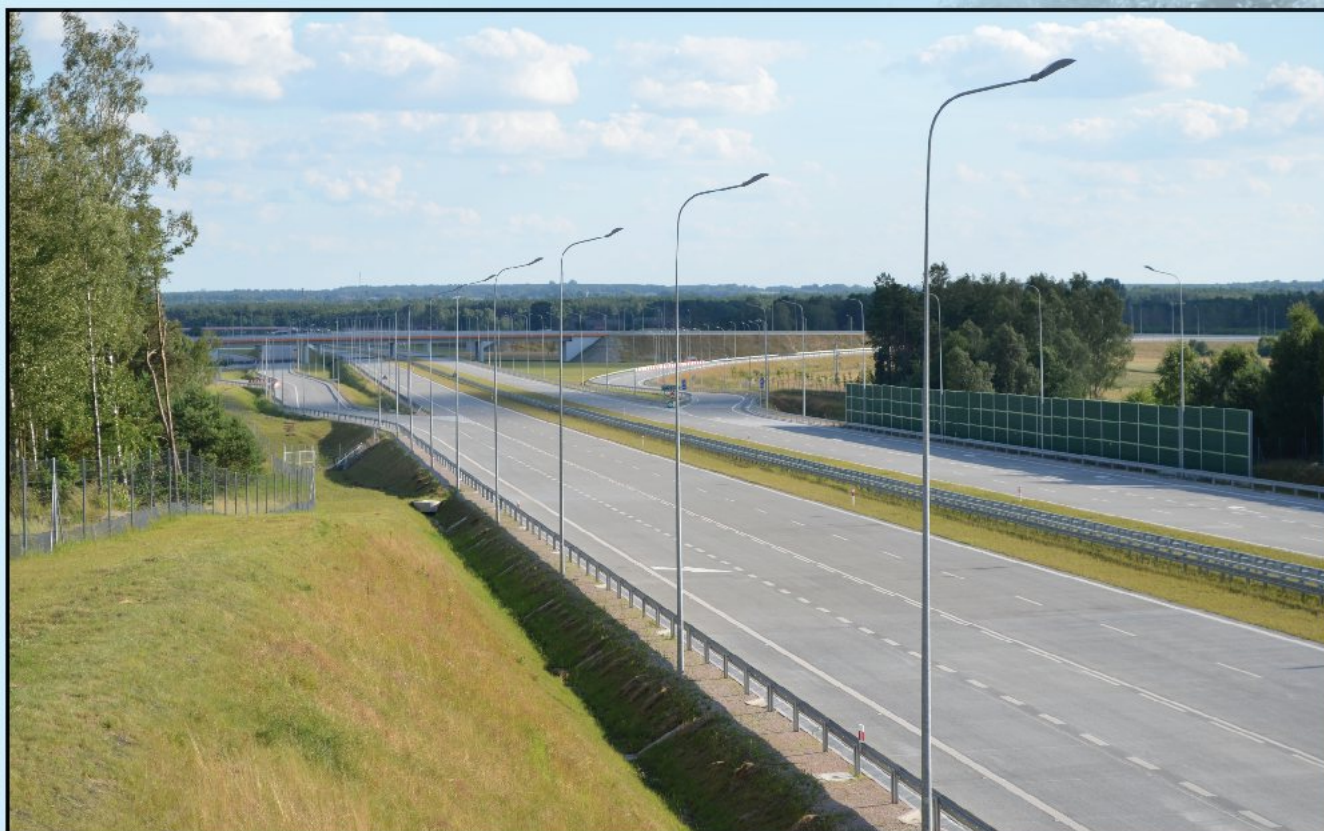
Odcinek autostrady A1 przy węzła z trasą S8 pod Romanowem Section of Motorway A1 at the junction with Expressway S8 near Romanów
