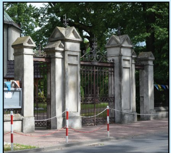
Brama przy kościele św. Stanisława Churchyard gateway at St. Stanislaus church
