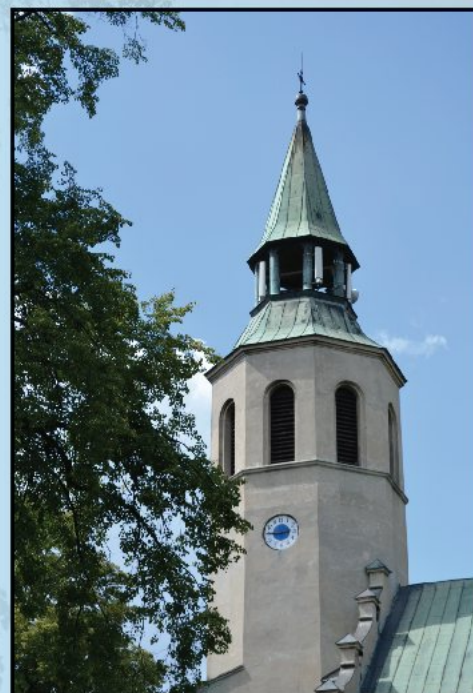
Wieża kościoła parafialnego w Rzgowie Tower of the parish church in Rzgów
