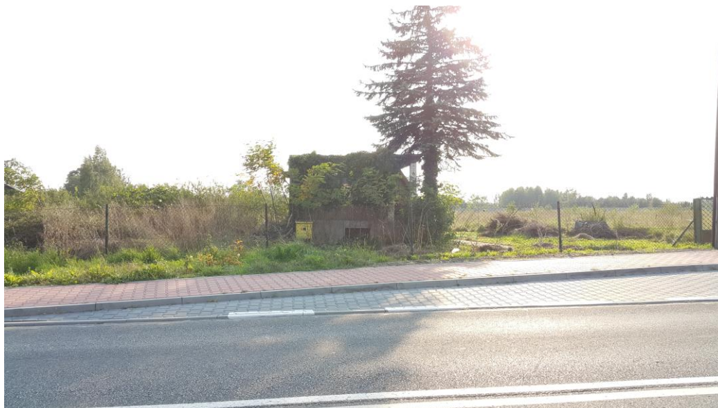
Zdjęcie nr 2. obszar objęty opracowaniem widok od ulicy Rudzkiej - istniejący budynek
